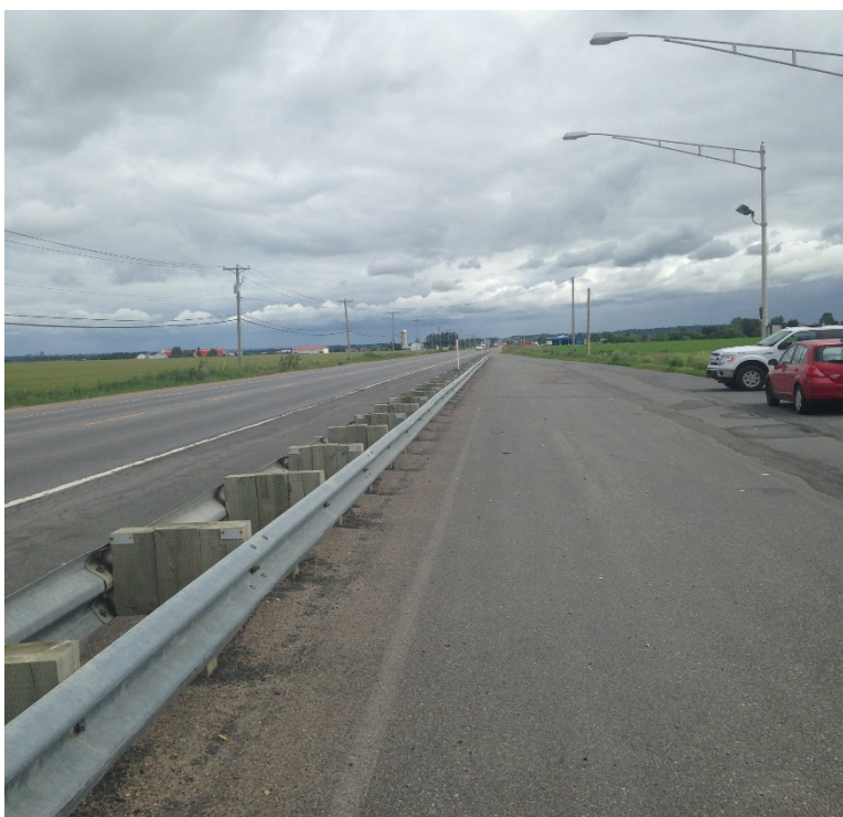
Photo 2 : Aire de contrôle vue vers le Nord
