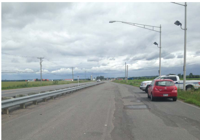
Photo 3 : aire de stationnement à droite de l'aire de contrôle
